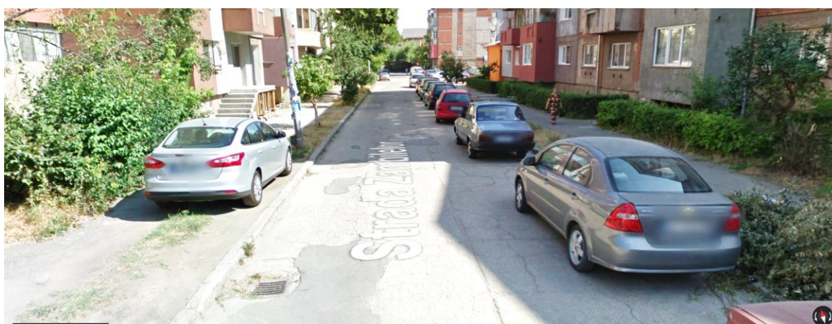
Figura 28 - Strada Zambilelor: stradă în stare rea, cu profil îngust ce poate fi transformat în ocazional carosabil (trama secundară). Parcare ad-hoc pe aliniamentul verde. Sursa – Google Maps
