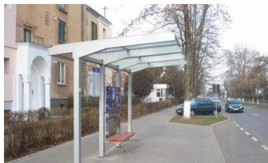
Figura 43 - Stație TP. Sursa foto: Google Maps
